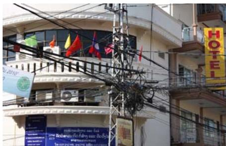
電線がスパゲティ状に絡まっていて、送電効率を落としている。
