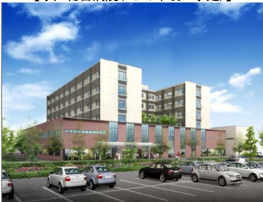
【水戸総合病院(2010年竣工予定)】
