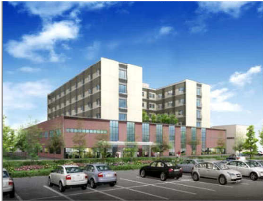
【ひたちなか総合病院(2010年竣工)】
