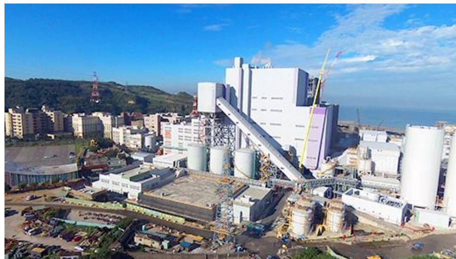
台湾電力の林口火力発電所
